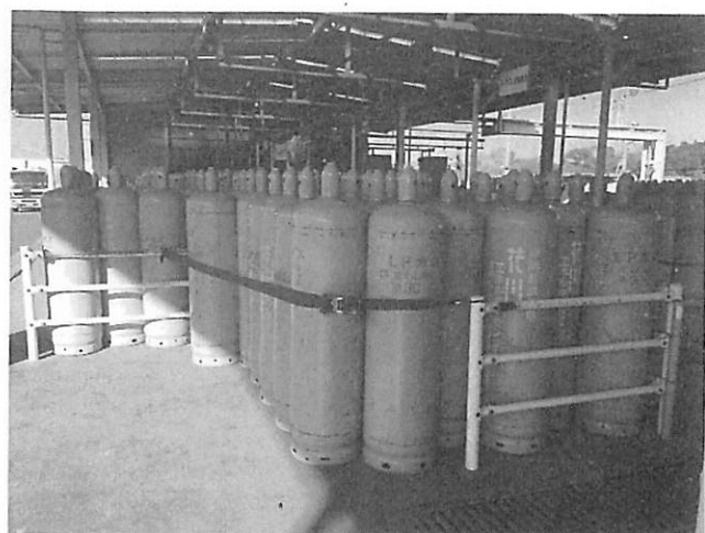
写真7 ガードパイプとベルト
