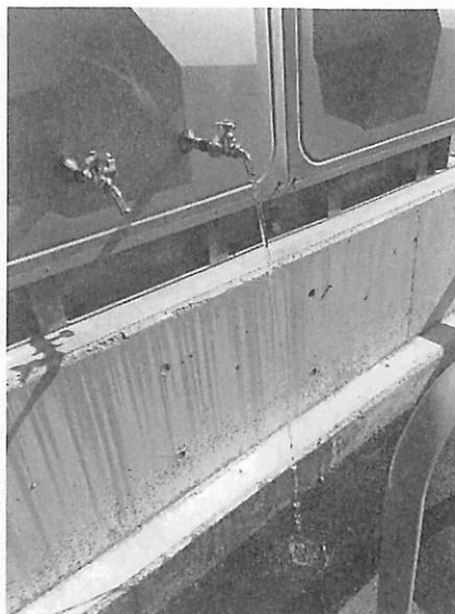
写真9 取り付けた蛇口
