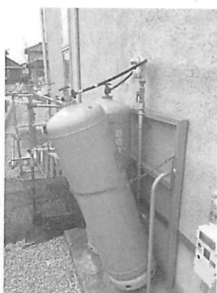
写真3 ボンベ転倒防止策
